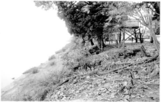
収蔵庫予定地 No.2（メコン河の浸食の危険性を含んでいる。）
