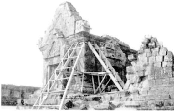
緊急的修復作業（1997年に設置）
