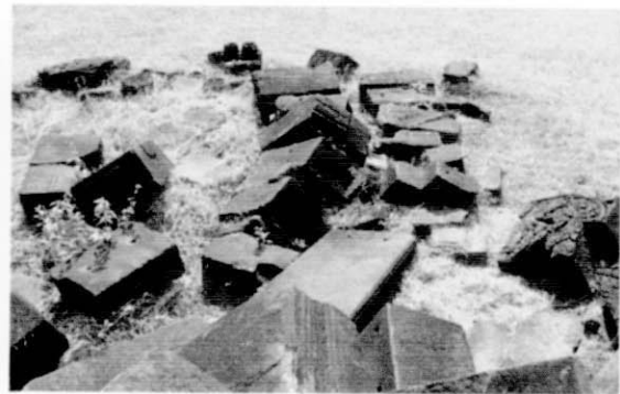
北宮殿入口部崩落箇所
