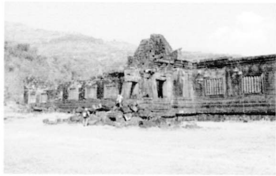
修復作業予定箇所（北宮殿入口部）
