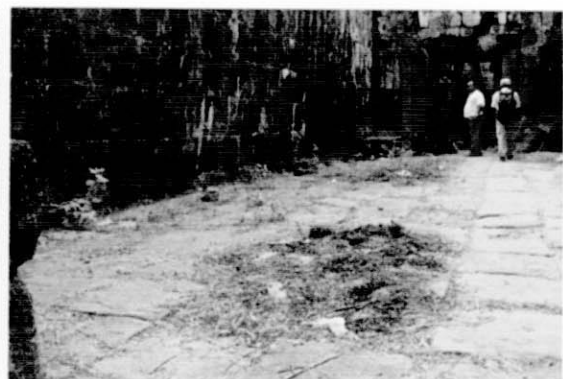
祭り後の歴史的建造物内部での焼き火跡
