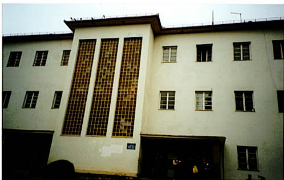
①既存仮校舎
