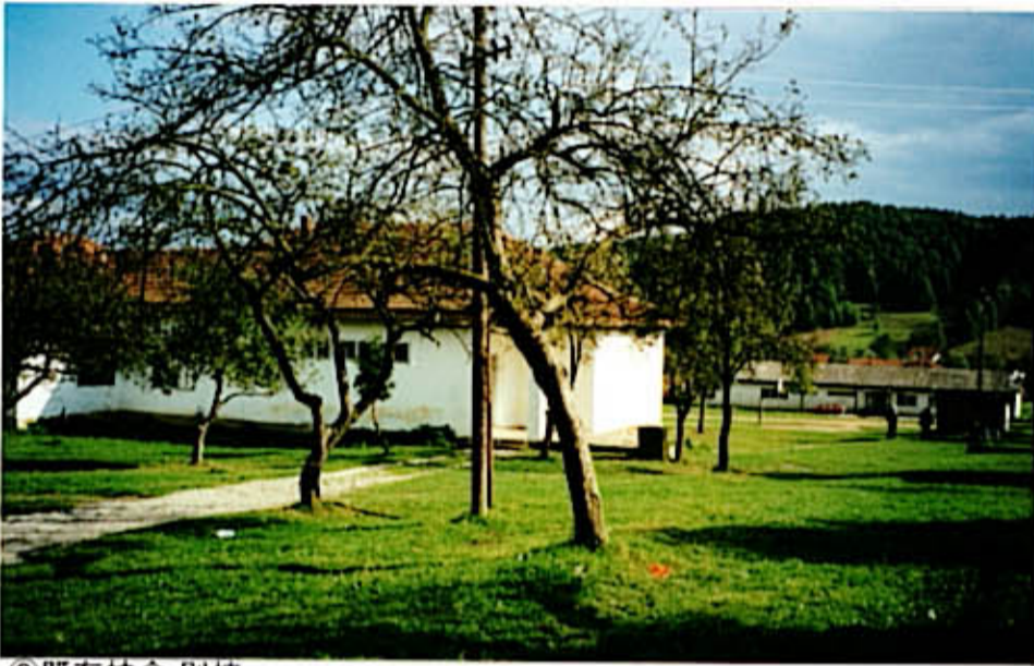
③既存校舎 別棟
