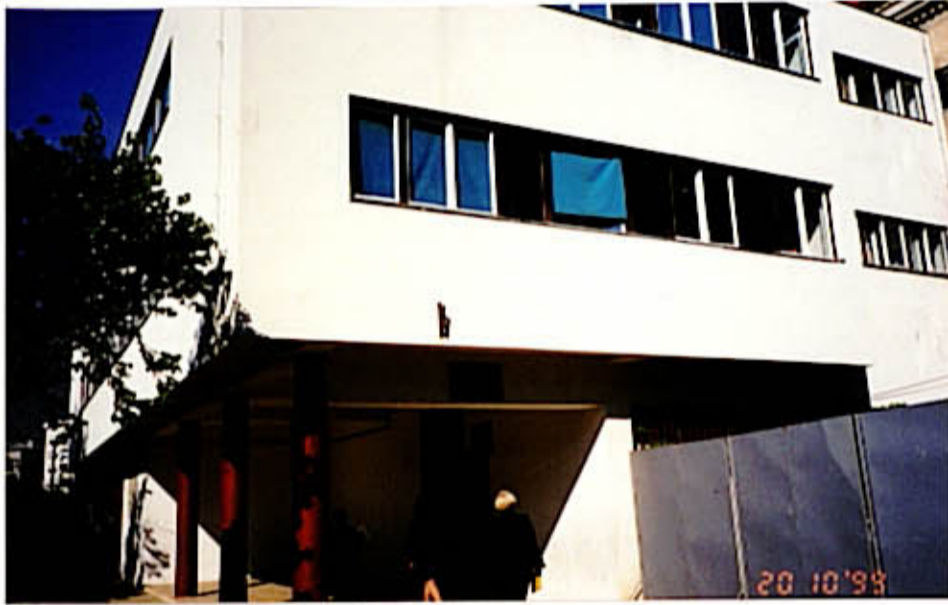
③既存仮校舎（ムンシバル施設に隣接）
