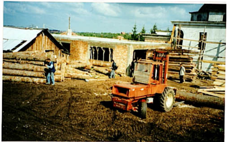
③サイト内既存施設（一部撤去予定）
