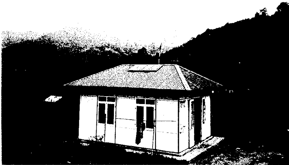
郵便局に設置され たPVパネル (BAC KAN 省)
