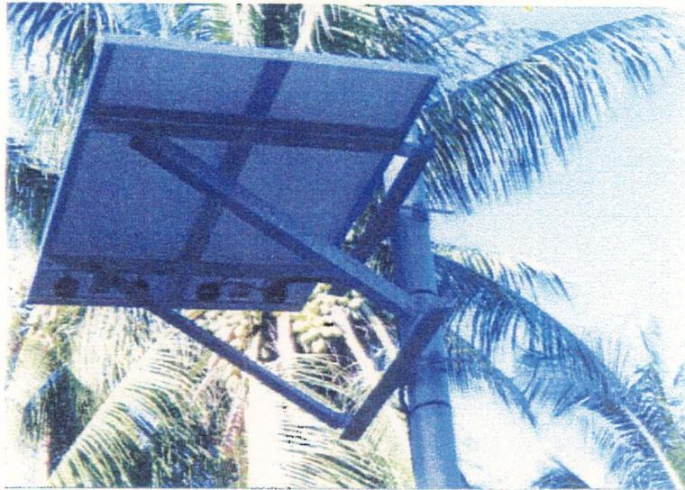
太陽電池アレイ(7年目でも架台の錆など発生していない)
