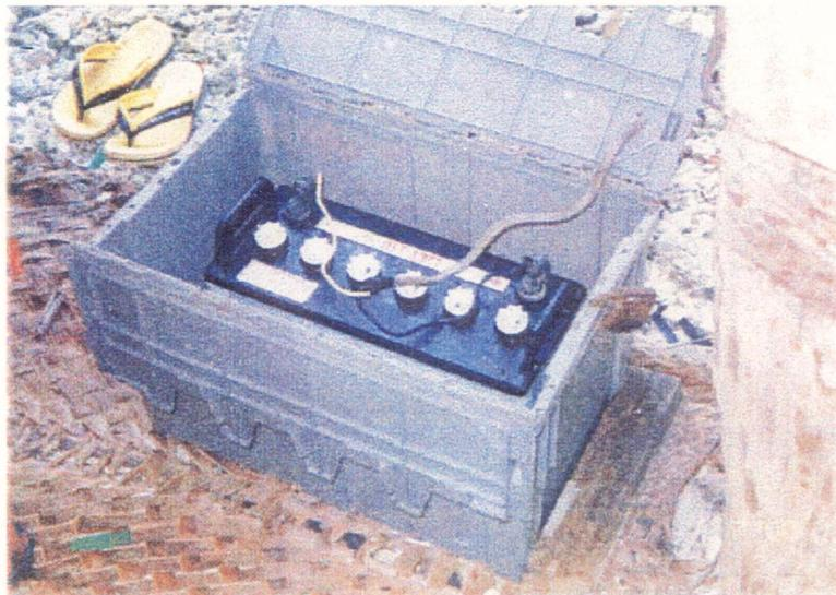
開発調査で設置したバッテリー(7年目でも充分機能している)
