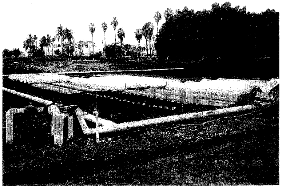
サカテベック試験場 灌水施設
