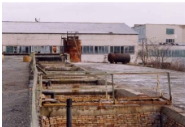
浄水場 沈殿池上屋 (運転休止施設)
