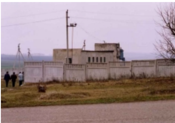
送水加圧ポンプ場 (建設中断施設)
