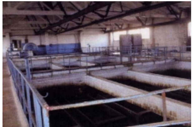
浄水場 ろ過池 (運転休止施設)
