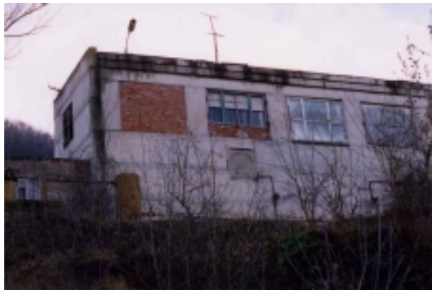
取水ポンプ場 (運転休止施設)
