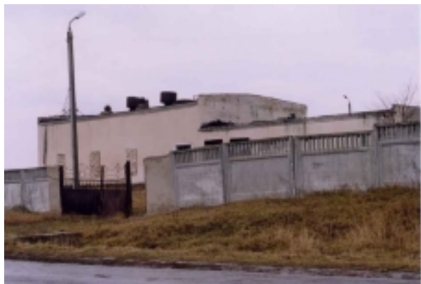
浄水場 入り口 (運転休止施設)
