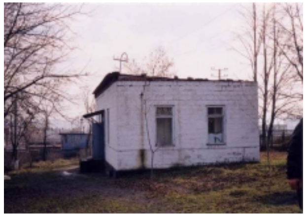
水質試験室 (建家)
