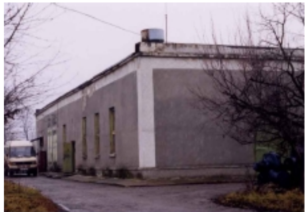
塩素貯蔵室 (配水池敷地内)
