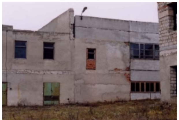
浄水場内建家 (建設中断施設)
