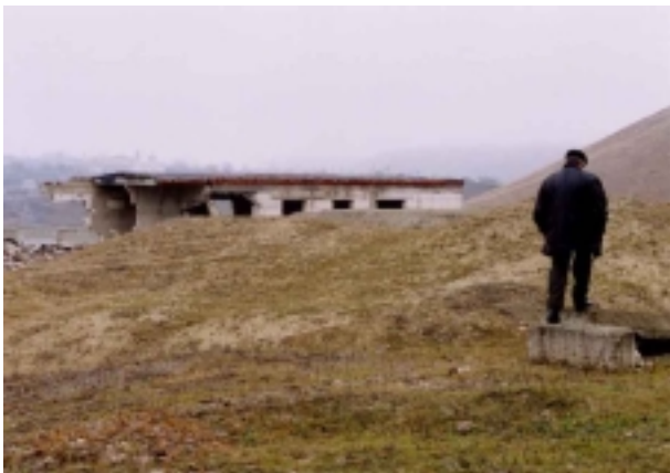
浄水場 浄水施設 (建設中断施設)
