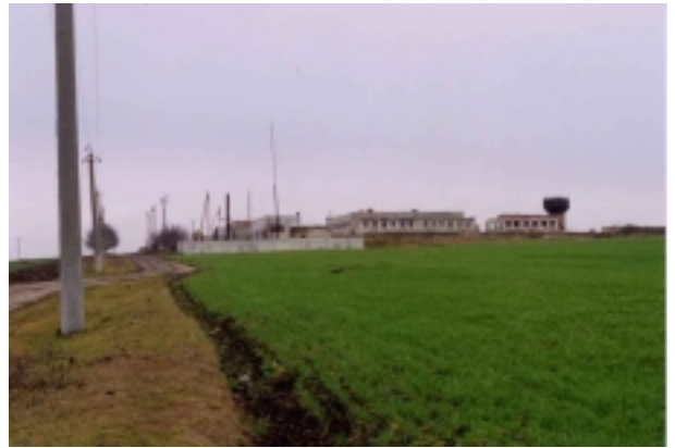
浄水場 全景 (建設中断施設)
