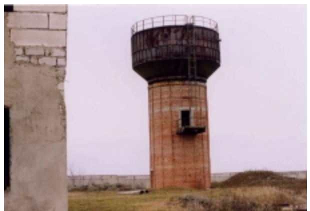
浄水場 逆洗浄水槽 (建設中断施設)
