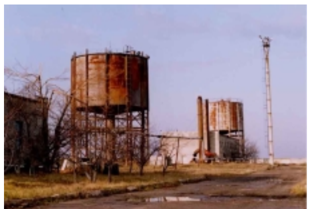
浄水場 逆洗浄水槽 (運転休止施設)
