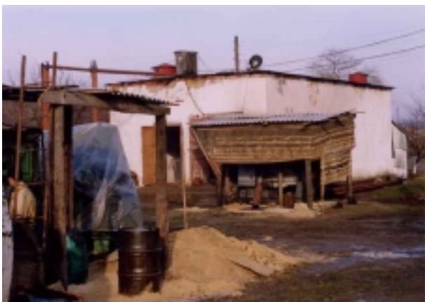
地下水集水ポンプ場
