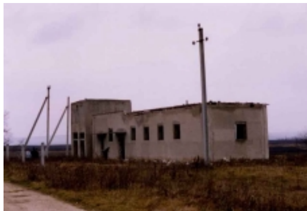
導水加圧ポンプ場 (建設中断施設)
