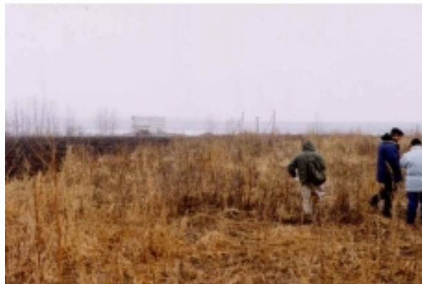
取水ポンプ場遠景 (建設中断施設)
