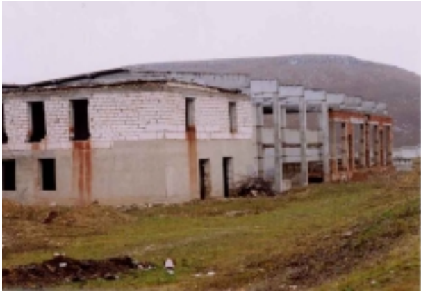
浄水場 浄水施設 (建設中断施設)
