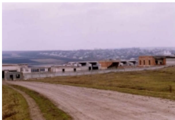
浄水場 全景 (建設中断施設)
