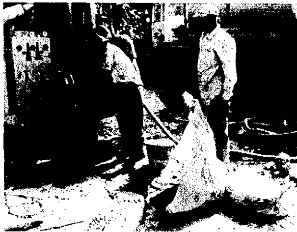
MJMB-E3孔 孔壁とケーシングの間に玉砂利充填
