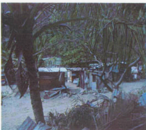
⑤計画地内にある漁業者が建てた漁具倉庫
