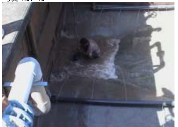
沈殿池排泥弁 その3 清掃後弁体をセットしているところ
