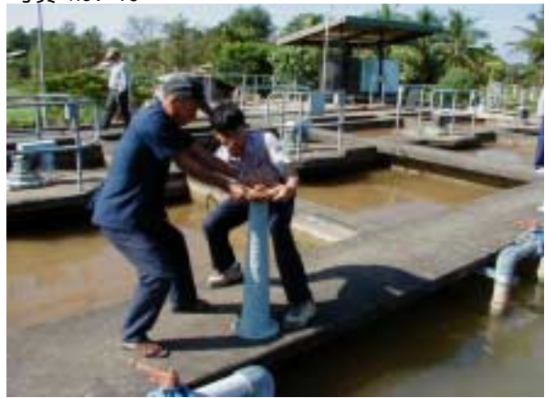
沈殿池排泥弁 その1 2人掛かりで開けようとしたが、開けられなかった
