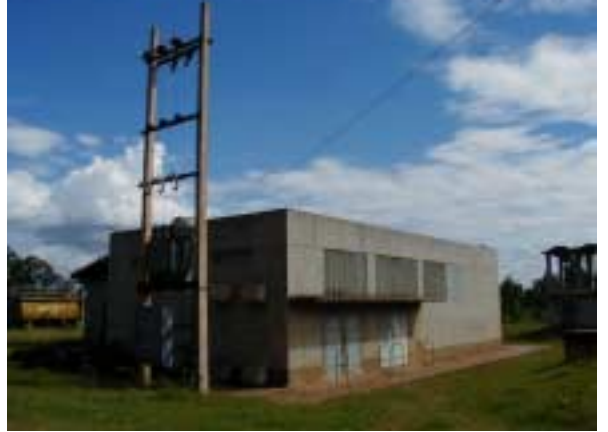
受電設備 - その1 電気棟 受電設備と自家用発電機設備が設置されている
