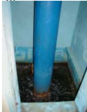
ろ過流量調節装置 - その1 4台とも正常に機能している。
