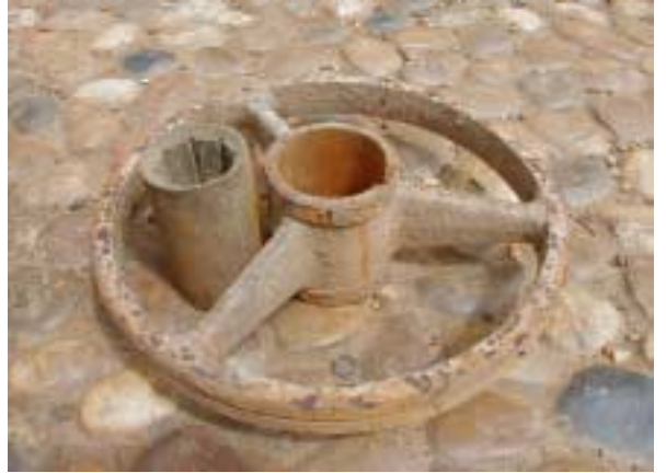
取水ポンプの中間軸受（オリジナルのもの）
