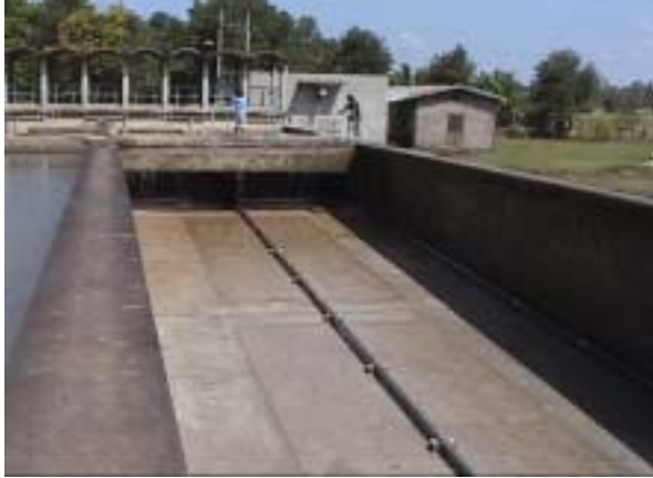
沈殿池洗浄用配管 集水トラフ付近まで布設されている
