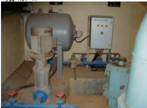
エアチャンバー用空気圧縮機 壊れたままになっている。
