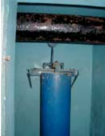
ろ過流量調節装置 - その2 てこの部分
