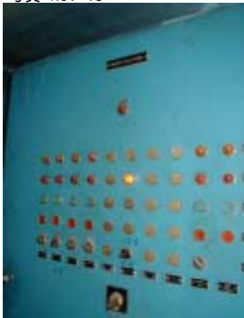
沈殿池洗浄ポンプ室内に設置されている 沈殿池洗浄ポンプ、急速攪拌機、緩速攪拌機 制御盤
