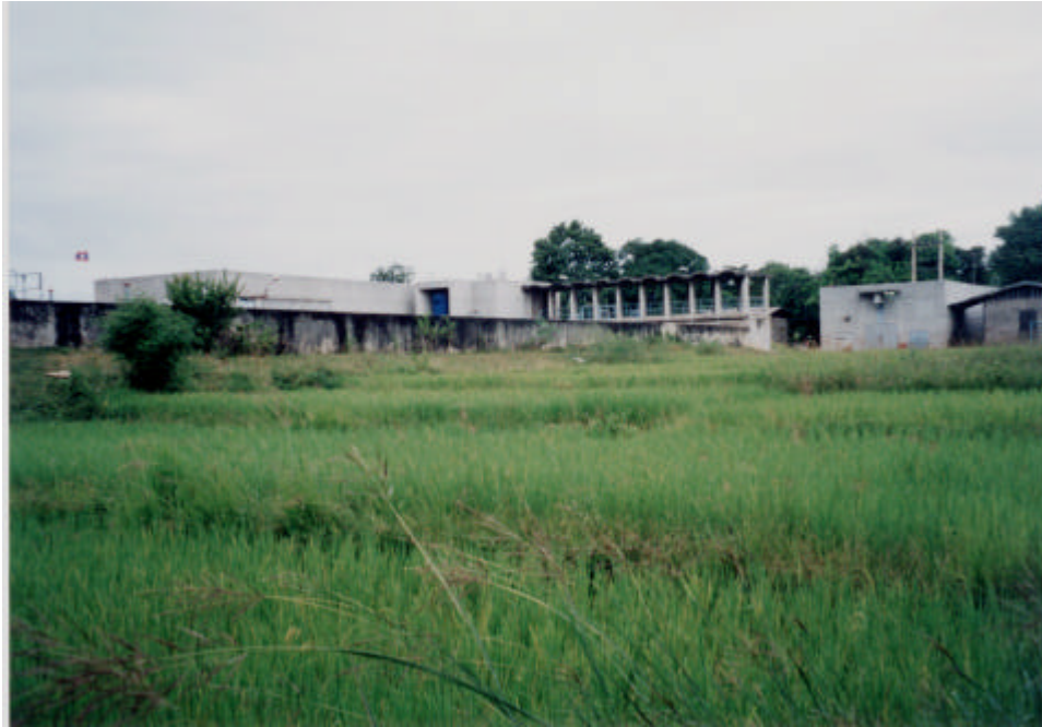
写真 3 ナケ浄水場遠景
