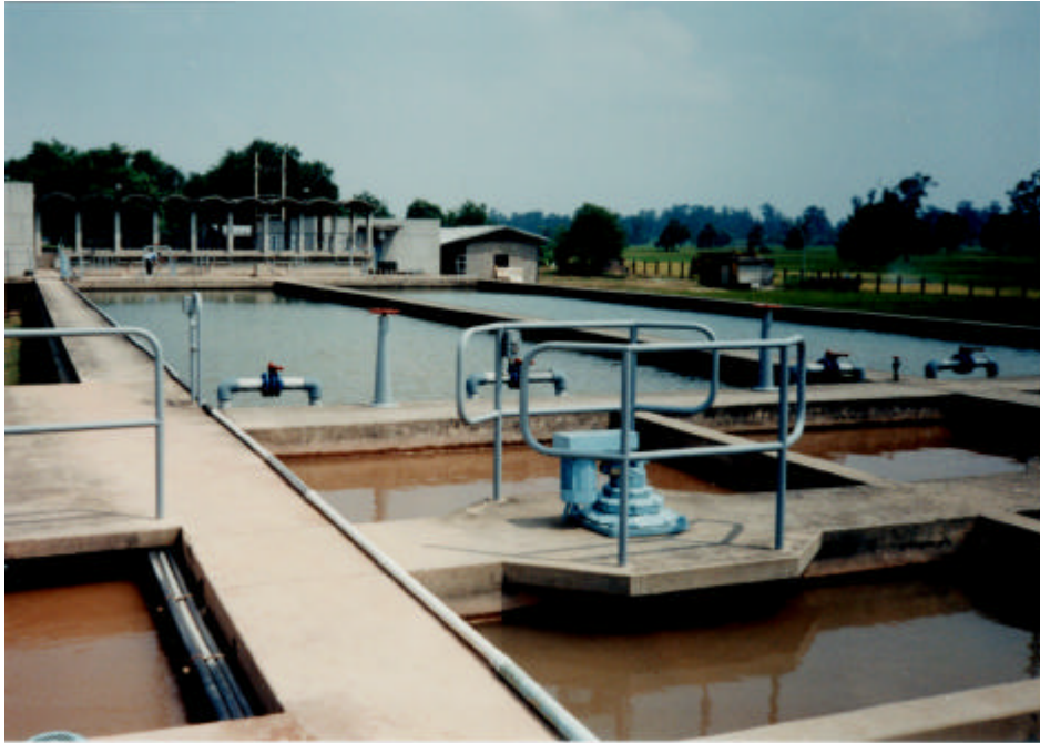
写真 5 ナケ浄水場内の様子（1） 手前側からフロック形成地、沈殿池、ろ過池（写真6を参照）
