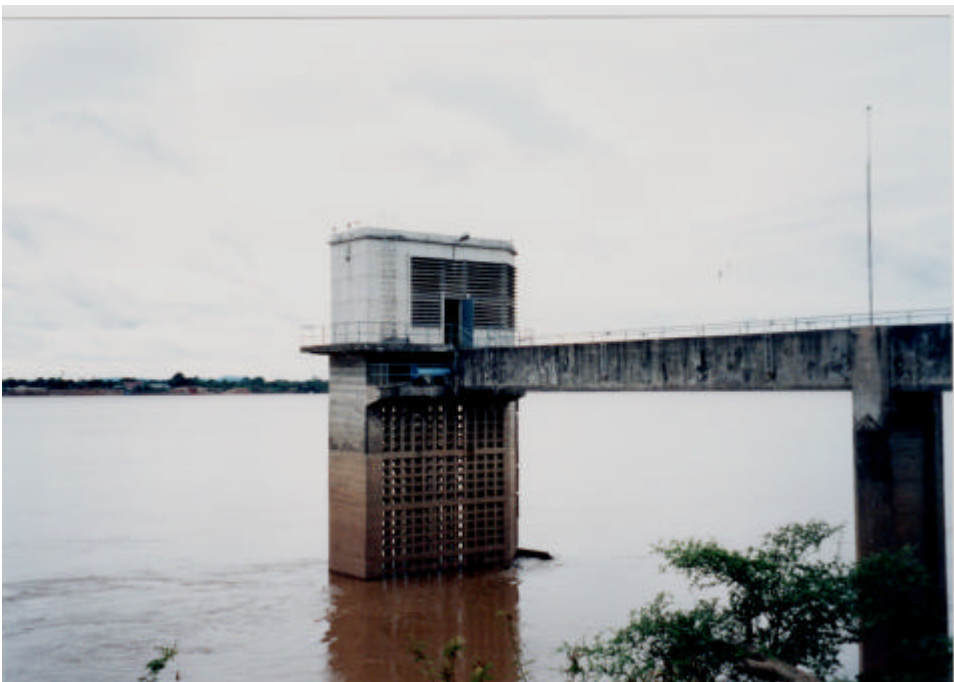
写真 4 ナケ浄水場取水塔
