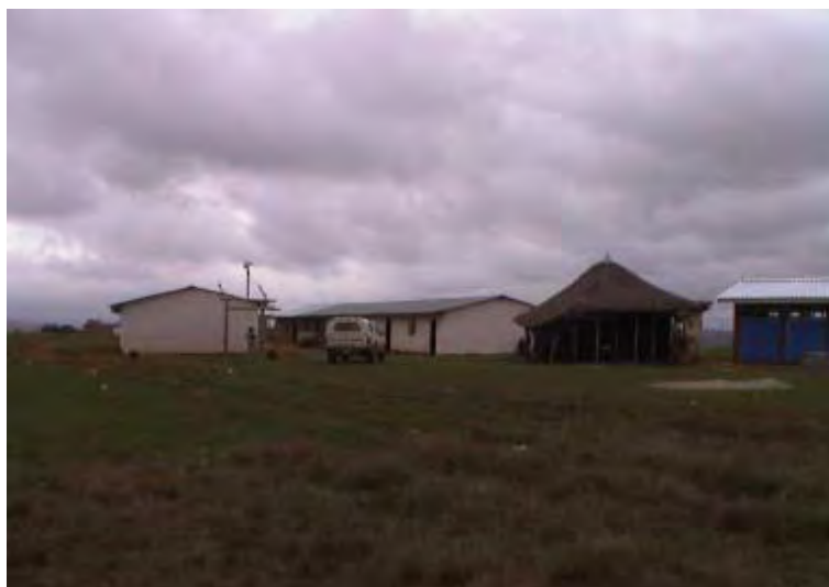
崩壊寸前のシリンダーハット教室。 ポールは電話用。
