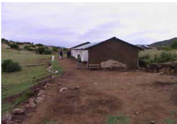
敷地は傾斜地の為、石による土留を設けている。
