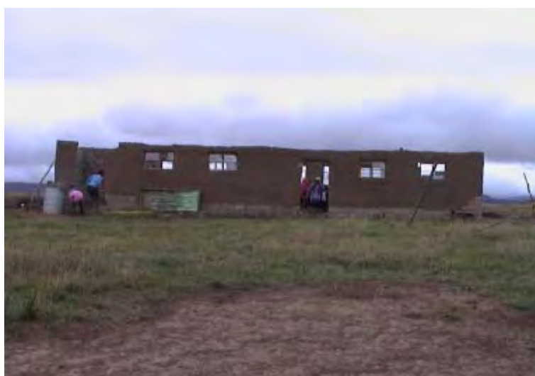
建設中のマッドストラクチャーの教室。屋根・窓ガラス等は未施工のため、防寒服を着て授業を行っていた。
