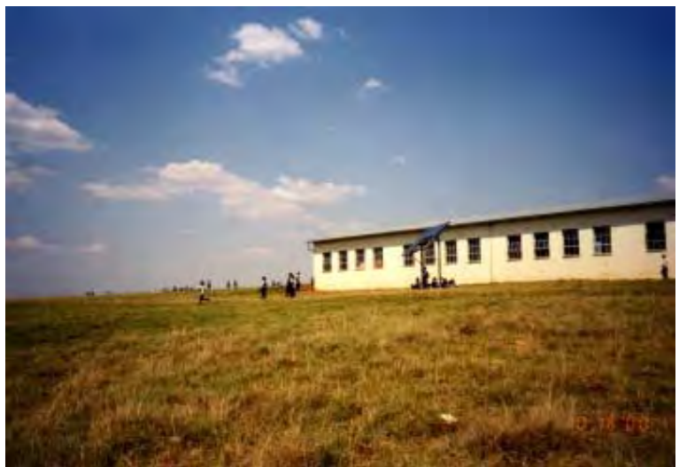
DOE 標準仕様の建物。ソーラー設備、給水タンク付き。
