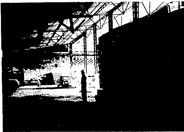
写真3. UTCAH 保管倉庫 内部
