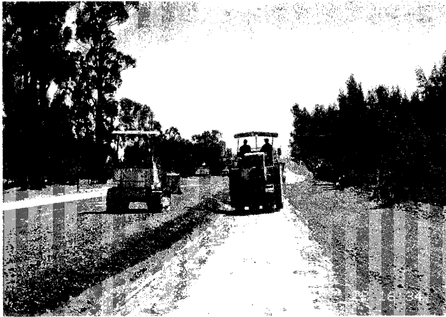
無償資金協力道路建設サイト
