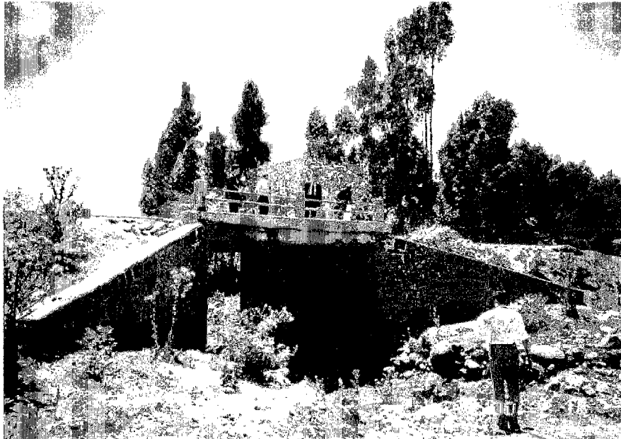
OJTサイト（橋梁）
