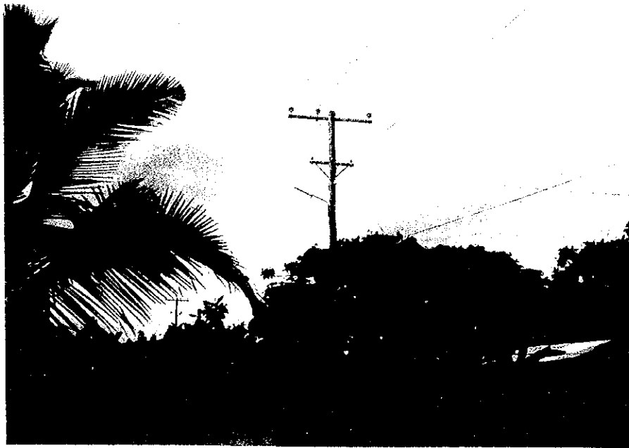
マノノ島周辺に整備された配電線
