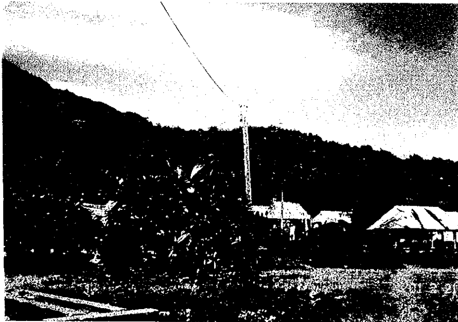
村落内に整備された配電線網 (アポリマ島)
