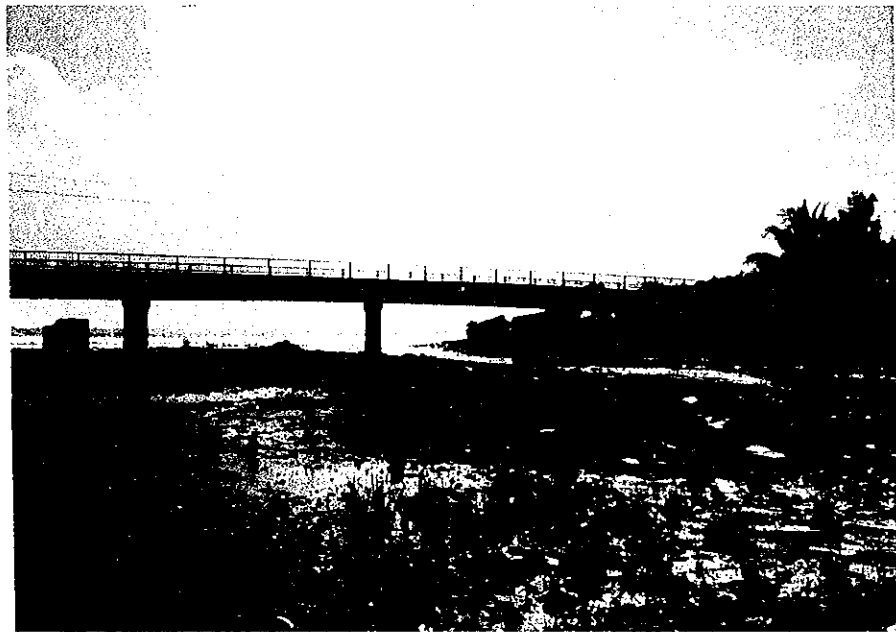
写真-3.2.5(2) Namo川河口付近
