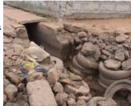
Caniveau situé le long de la route
