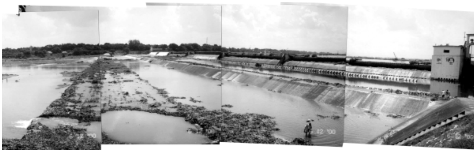
左岸側よりダムを撮影
