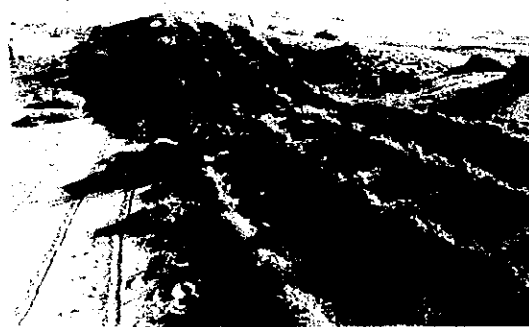
草格沙障 (方格沙障) の概観
