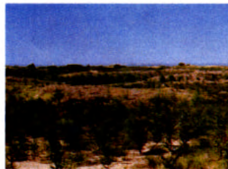
施工1年後の概観
