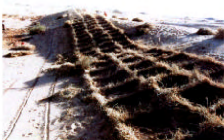
草格沙障 (方格沙障) の概観
