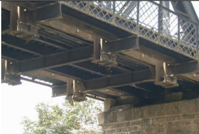
既存トラス橋下面現況
