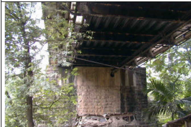
既存橋脚現況（左岸側）
