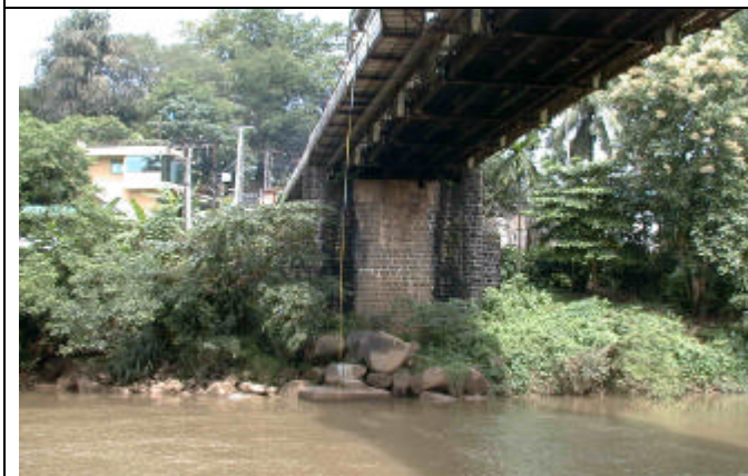
左岸側橋脚付近現況（転石）
