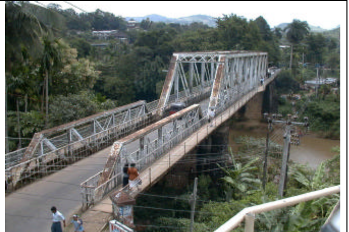
No.239 ムワガマ橋全景
