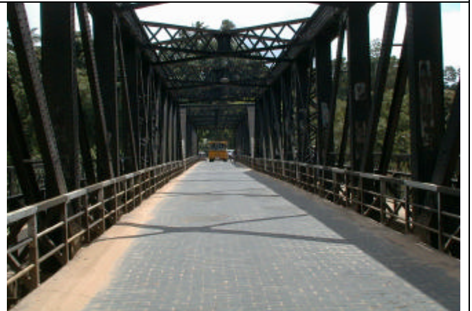
全幅現況（車道幅員：4.85m、歩道幅員： 2@2.08m ）
