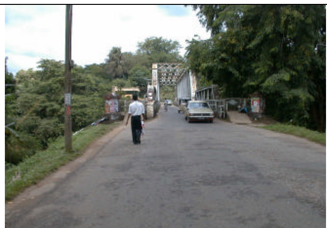
右岸側道路現況 B369 号線（ラトナプラ側より）
