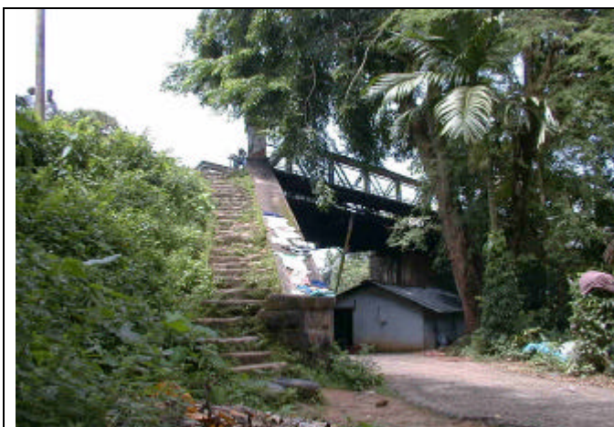
起点側橋台前面（右岸側）既設生活道路
