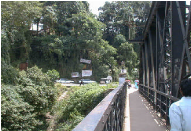
既存橋梁歩道部現況
