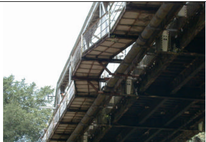
橋梁下面現況（水道管添架）
