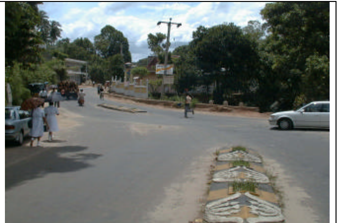
左岸側道路現況 A5 号線（ペラデニア側）
