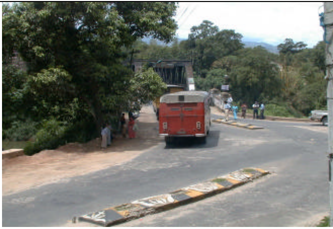
起点側取り付け部（左岸側）
