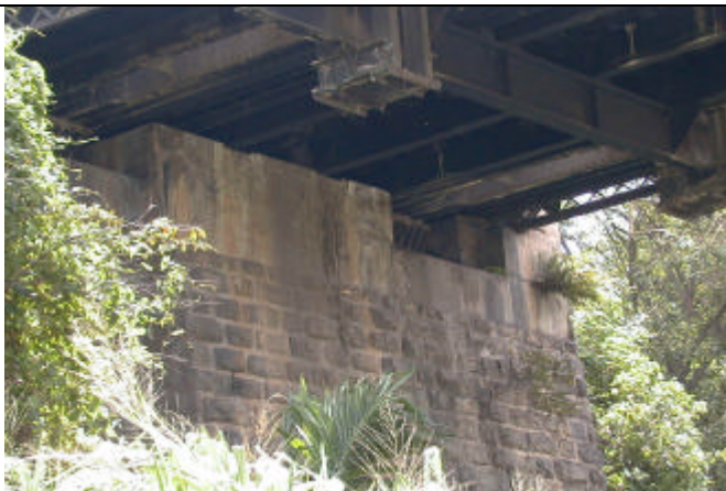
既存橋台現況
