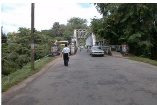
ムワガマ橋 ラトゥナプラ側アプローチ道路
