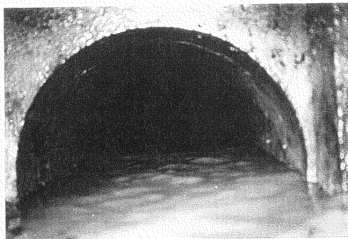
導水管の着水井接合部
