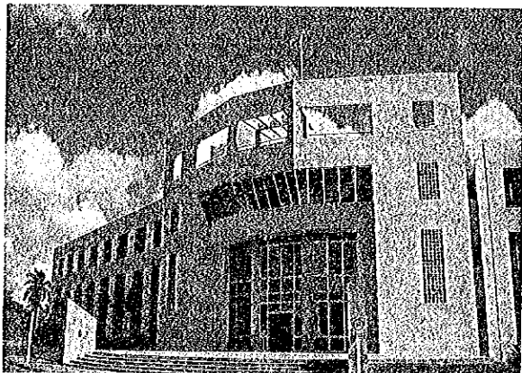
首都・ベルモパンにあるベリーズ外務省、財務経済開発省の合同庁舎。協力隊の受入窓口省庁は外務省となっている。建物上部は首相執務室である
