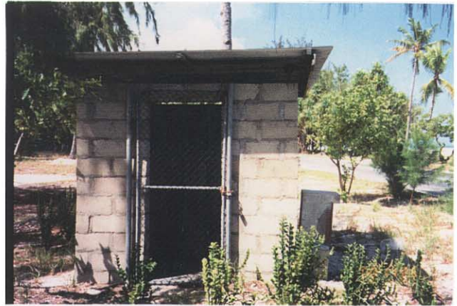
既設遮断器盤収納小屋
