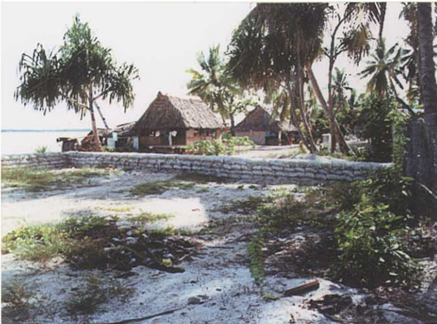
高潮対策用土嚢
