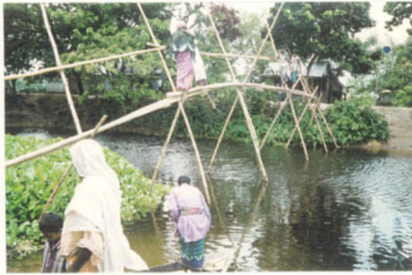
人道橋 橋梁番号 New (39km)
