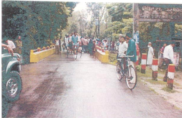
交通量が多く取付道路は2車線であるが、橋梁部がせまくなっている。(レンガ積み橋台は亀裂有り) 橋梁番号 700825
