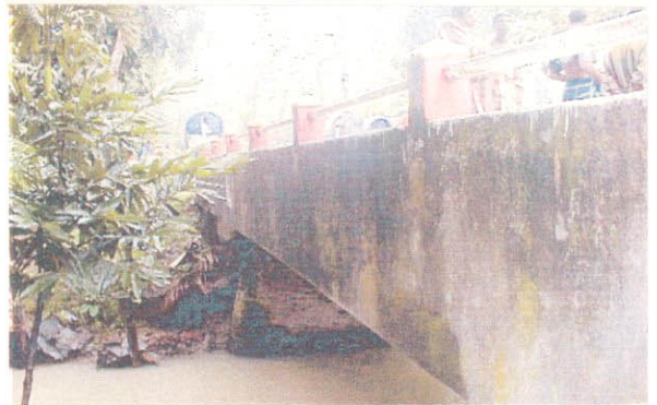
交通量が多く取付道路は2車線であるが、橋梁部がせまくなっている。(レンガ積み橋台は亀裂有り) 橋梁番号 700825
