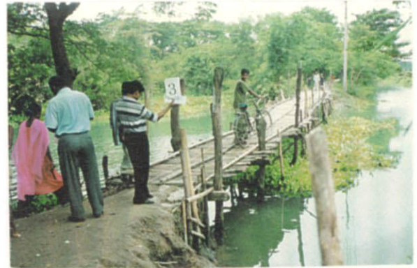
リキシャ通行可能な橋 橋梁番号 New
