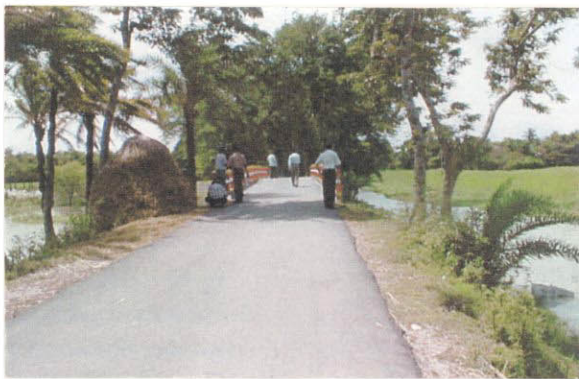
アスファルト舗装
