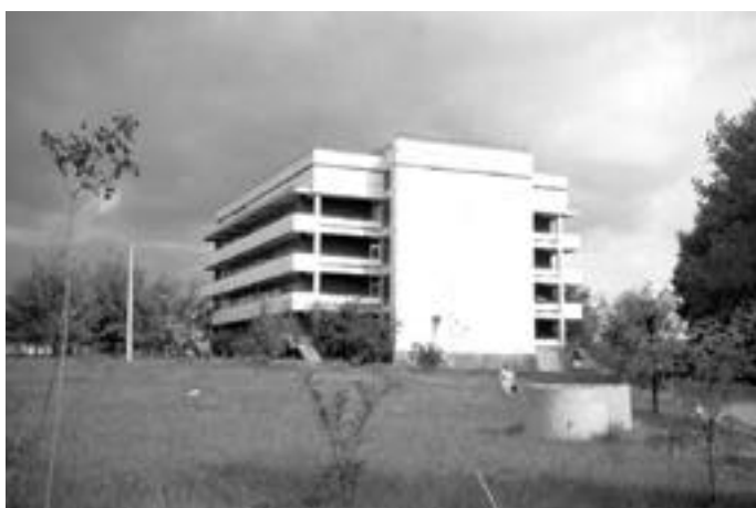
7. カゲール県病院、産婦人科棟
