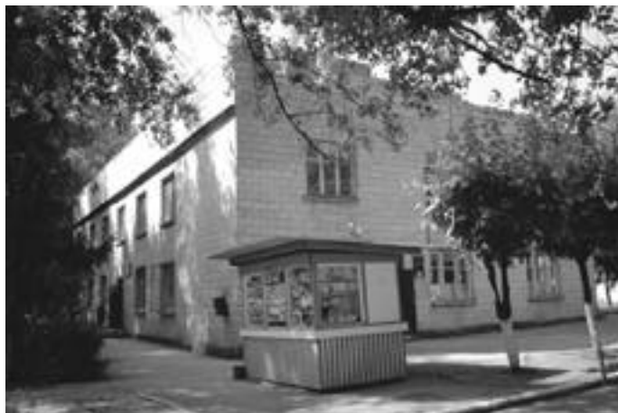
4. ウンゲニ県病院、臨床検査・X線検査棟
