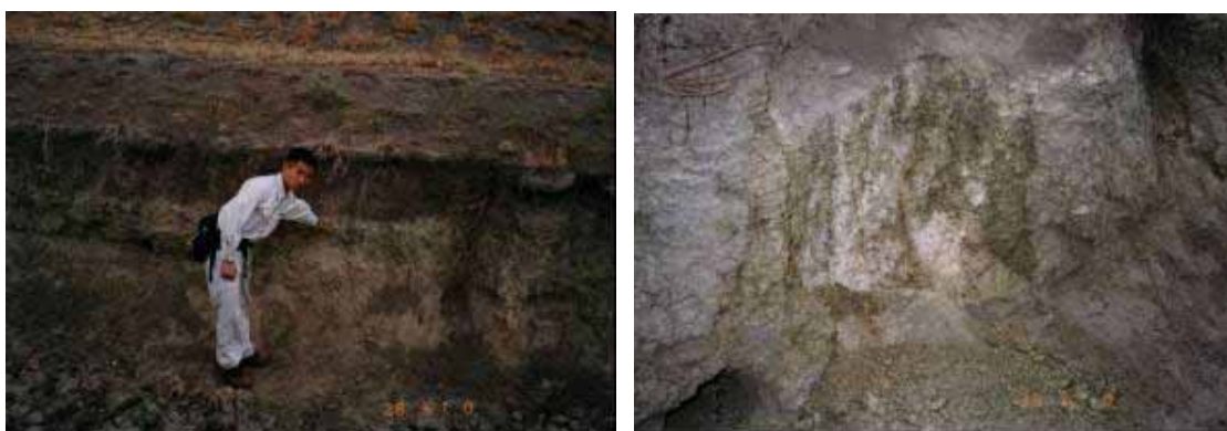
図 2-5. ポゾラナの堆積状況 (25Km 地点)
