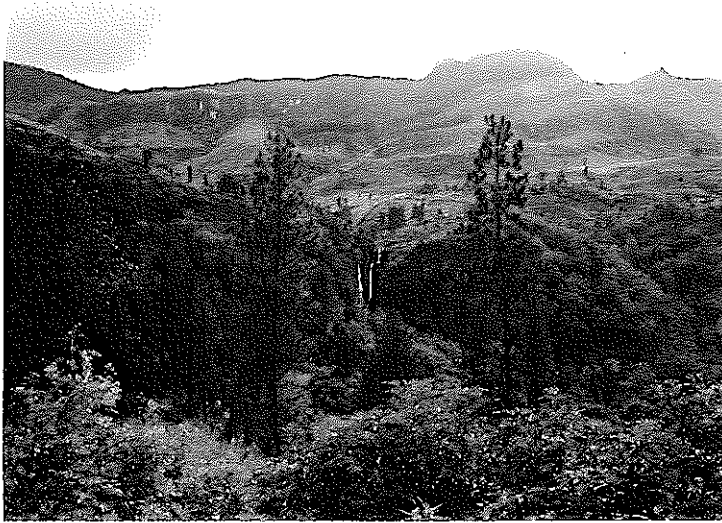
Upper Kotmale 発電計画の Pundal Oya Falls 溪流取水地点
