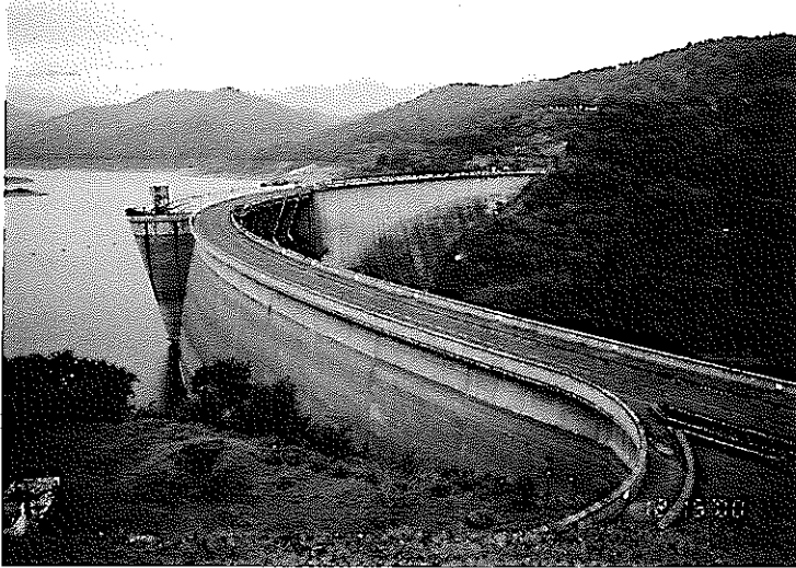
右岸下流からの Victoria アーチダム ム全景
