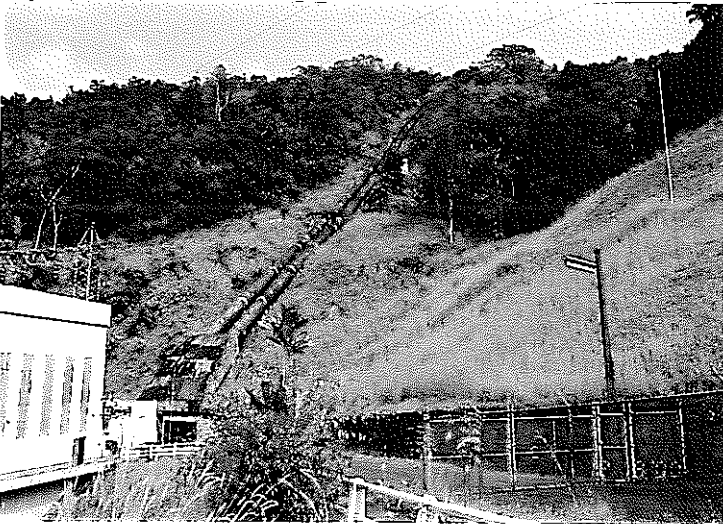
Samanela 発電所の水圧管路全景
