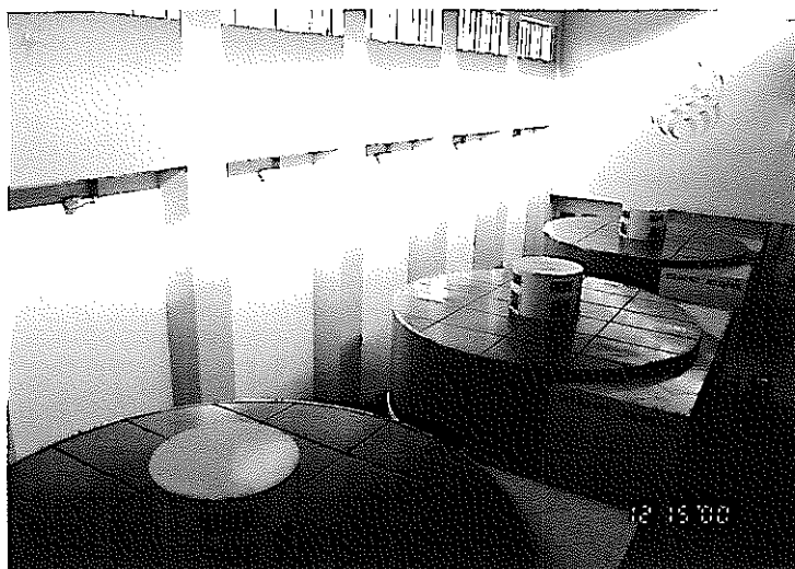
Victoria 発電所内 3 台の発電機
