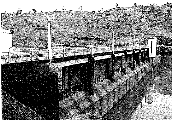
貯水増量のためダム洪水吐越流天端 に約 2m の木製ゲートを設置
