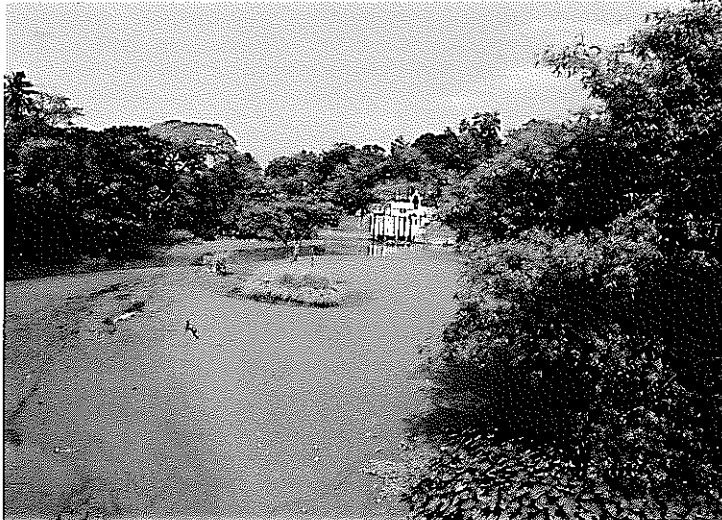
Ukuwela 発電所放水口付近の支流入江堆砂状況
