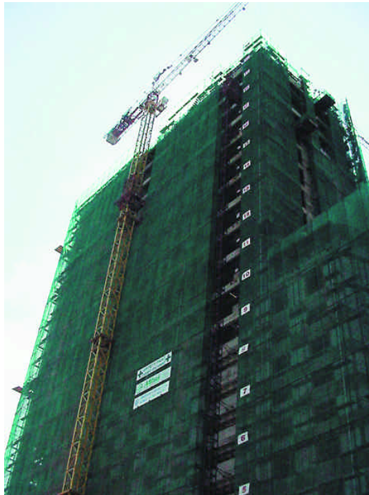
写真8 「Proposed Office Development for SITHMA Development (PVT)」スリ・ランカでの建設現場視察先。日本の建設会社が施工する23階建ての銀行オフィスビル建設現場。
