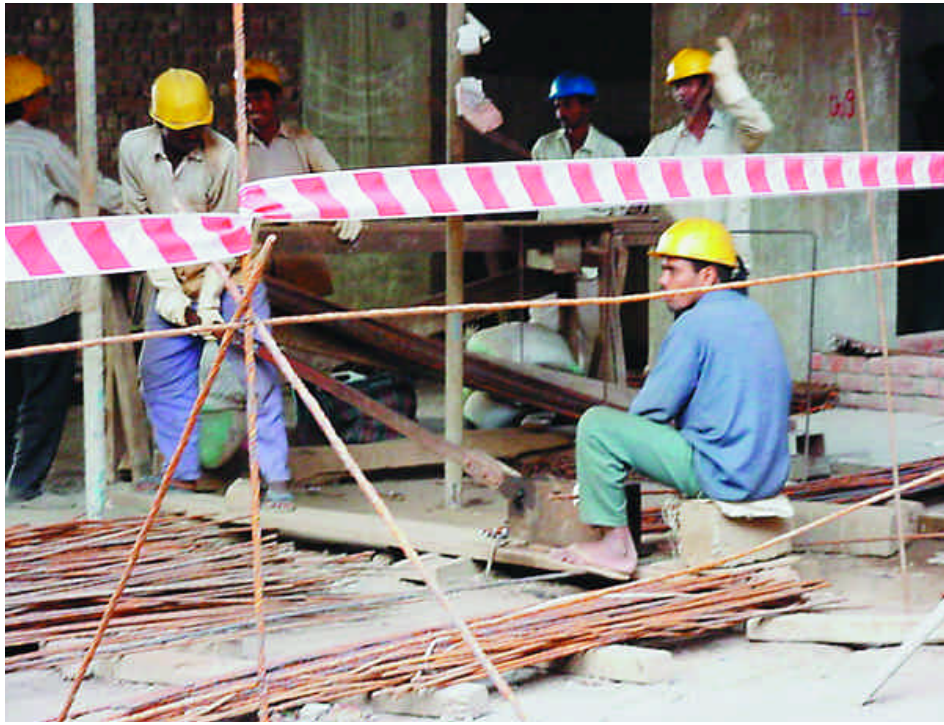
写真3 「Bharat Hotel Jobsite」の様子。皆ヘルメットは着用しているが、サンダルで作業をしている労働者をかなり見かける。
