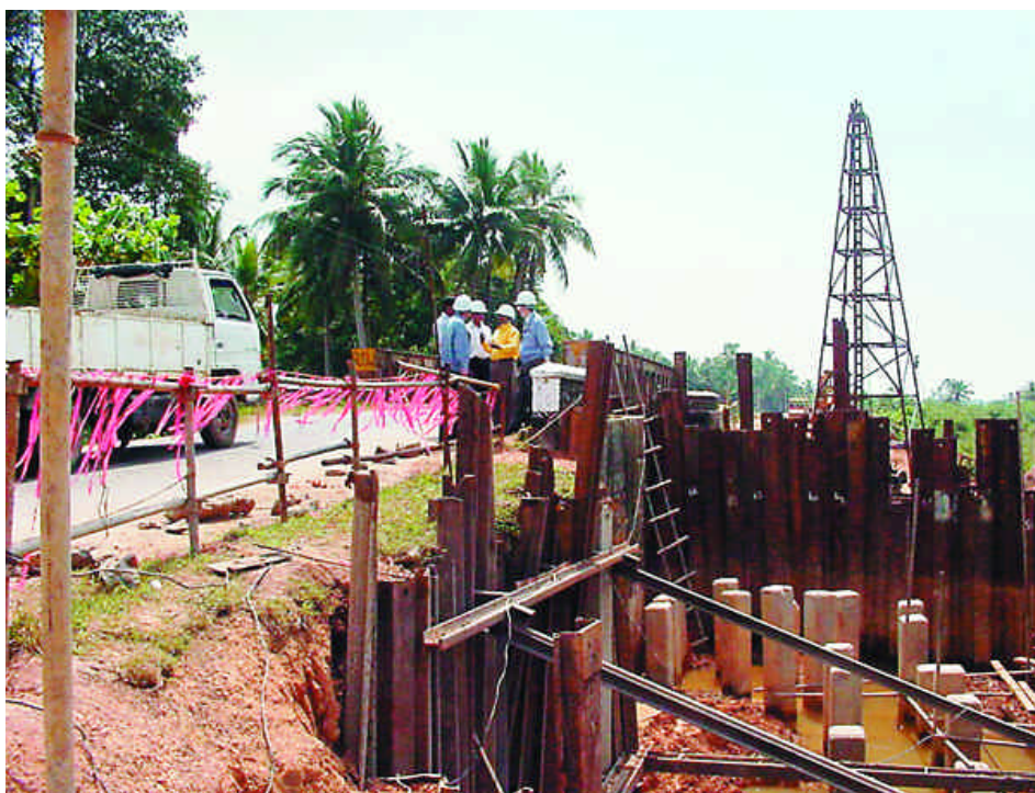
写真10 「Bridge Project in Bandavegama」スリランカ国家開発建設公社の帰国研修員が監理している橋梁建設プロジェクト。橋の長さ 19 m、アプローチが 300 m で約 15 人の労働者が働いている。
