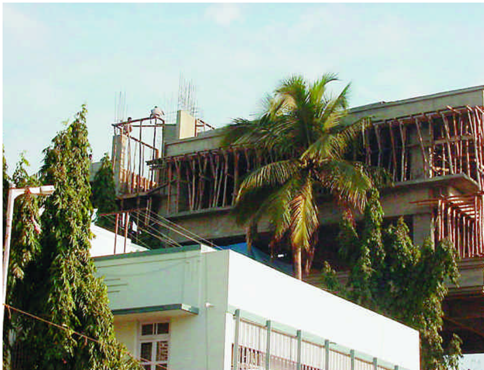
写真4 インドのムンバイの街中で見かけた工事現場。支柱に丸太等を使用し、足場は竹を使うのが一般的。
