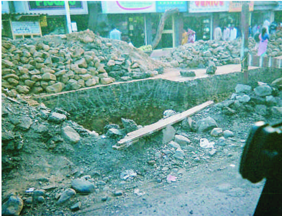
写真5 インドのムンバイでの下水管敷設工事の様子。土止め等は設置されていない。こうした現場では、女性や子供がサリー、サロン等にサンダルで作業をしているのをよく見かける。
