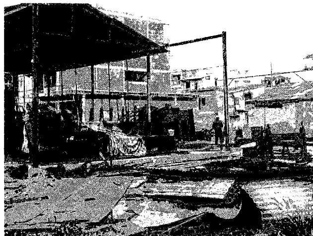
農業工学研究所 南部応用研究センター ワークショップ(仮設、郊外に新築中)
