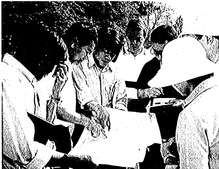
写真5 帰国研修員との合同メコン川現場調査の様子
