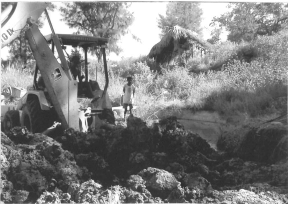
灌漑施設修復現場 (マナトト県)
