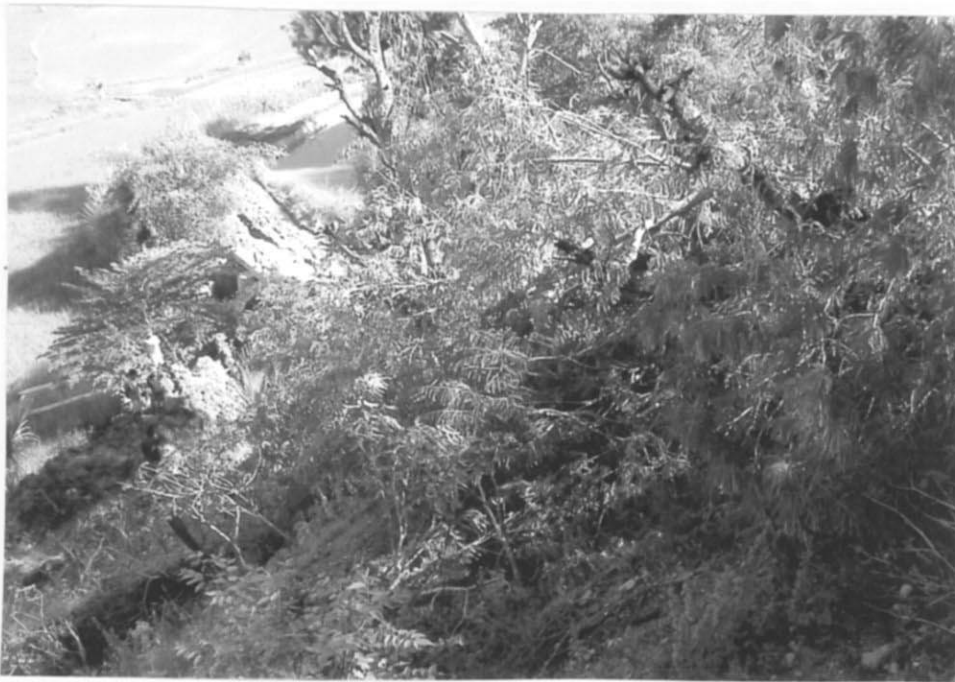
灌漑施設修復現場 (マナトト県)
