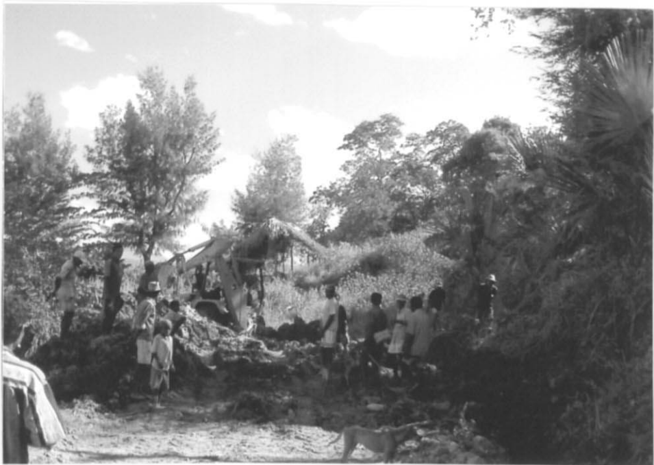
灌漑施設修復現場 (マナトト県)
