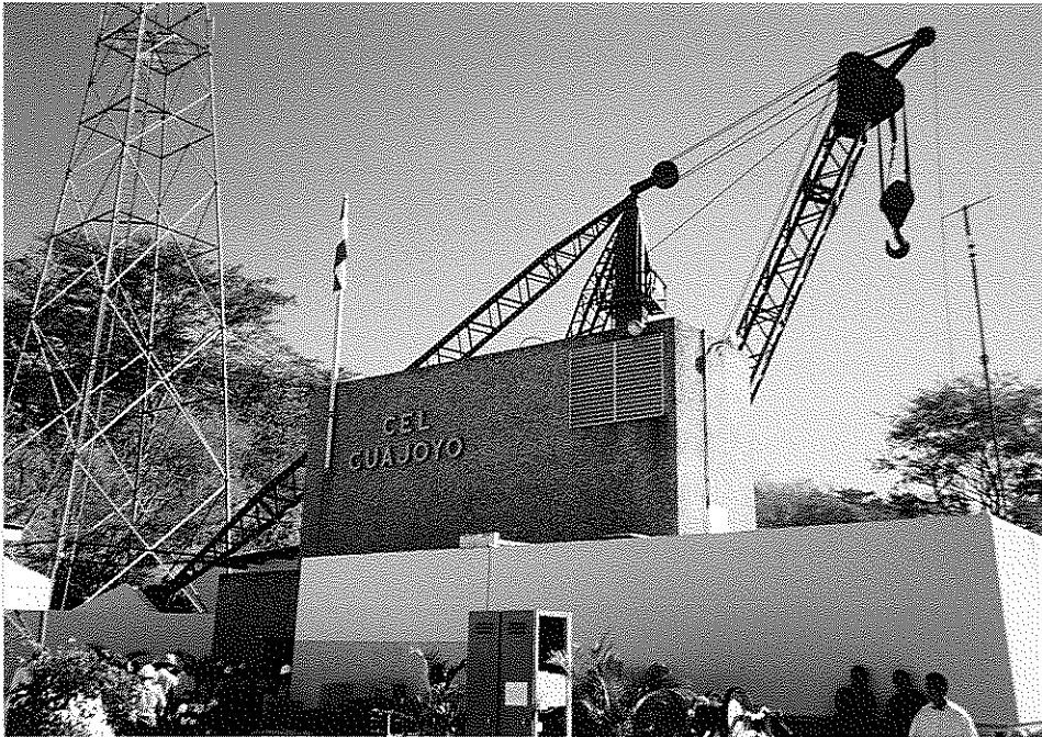
写真4 グアホージョ発電所
