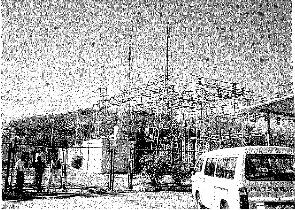
写真5 グアホージョ発電所変電設備
