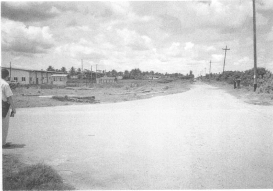
共和国通り・フィラデルフィア通り交差点から電話局（手前）と当敷地（奥手）を望む
