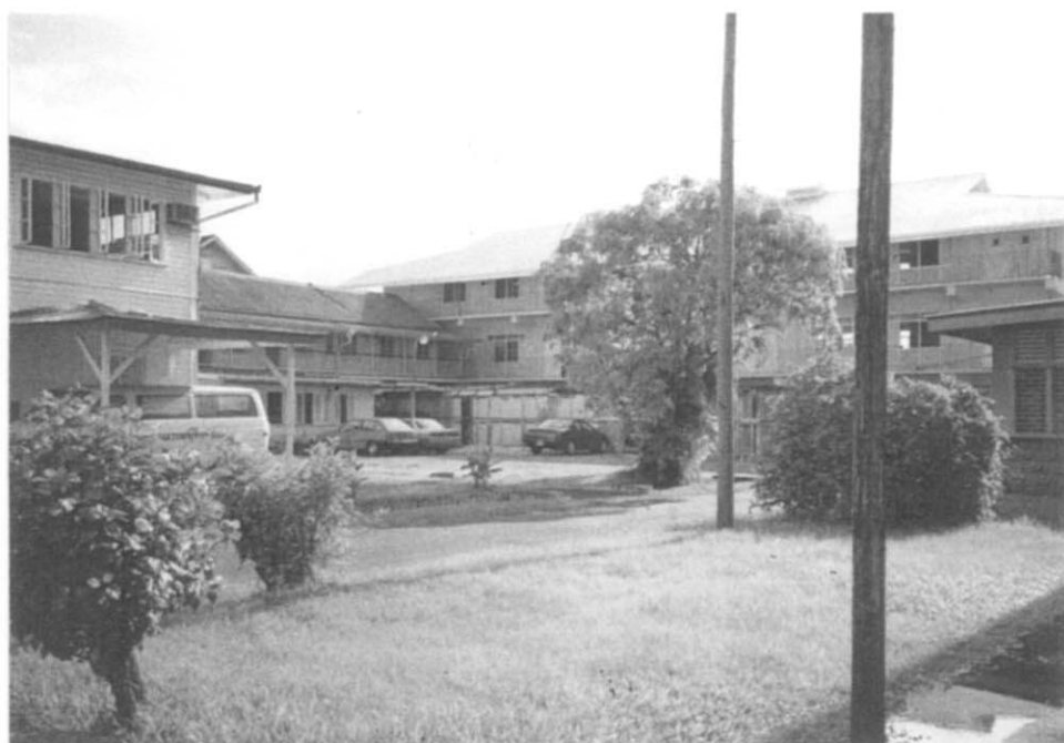
既存病棟（内科・木造3階建）
