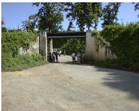
写真①: 国道 3 号線鉄道交差部
