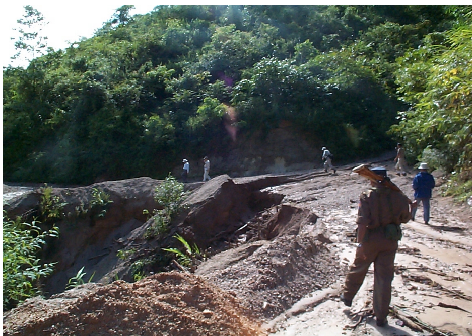
写真9：ラシオからコウカン地域を結ぶ地方道路34号線
