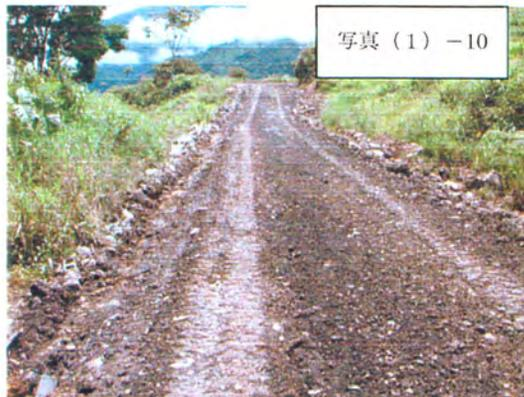
碎石撒き出しによる砂利舗装(転圧前状況)。締固まれば良質の舗装となるが、稀な事例(9月20日)。
