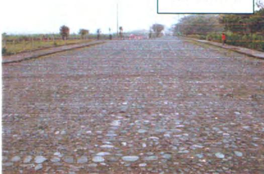
マカス近郊の玉砂利舗装道路。適度な径の材料を用い丁寧に転圧されており理想的舗装(9月21日)。
