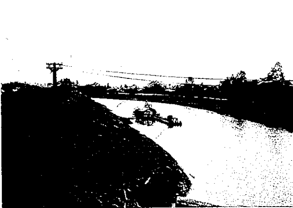
11) ポンプ場上流の導水路 (浚渫船により滞積土砂排除)
