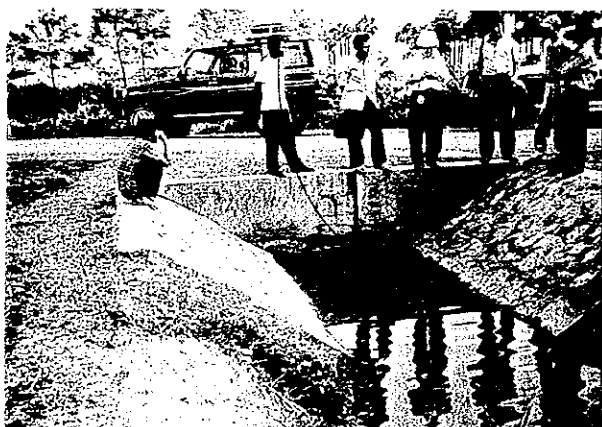
5) 二次水路から三次水路への分水口
