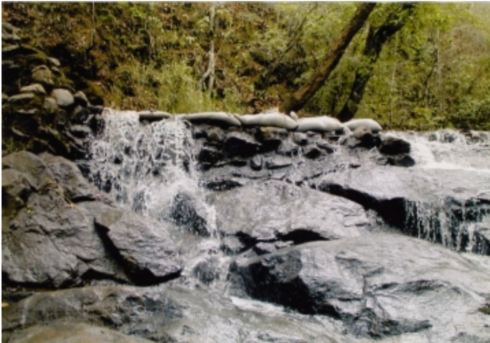
Matandani Mission 天然の岩を利用した 取水ダム
