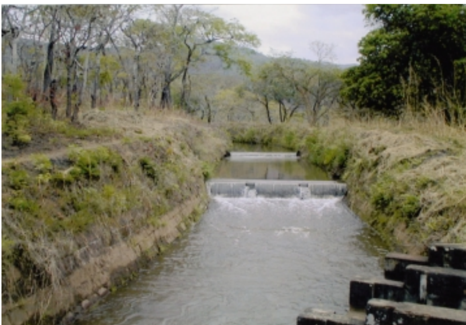
Matandani Mission 沈砂地 導水路の巾を広くし 流速を落としている。 手前のコンクリート 施設が取水口
