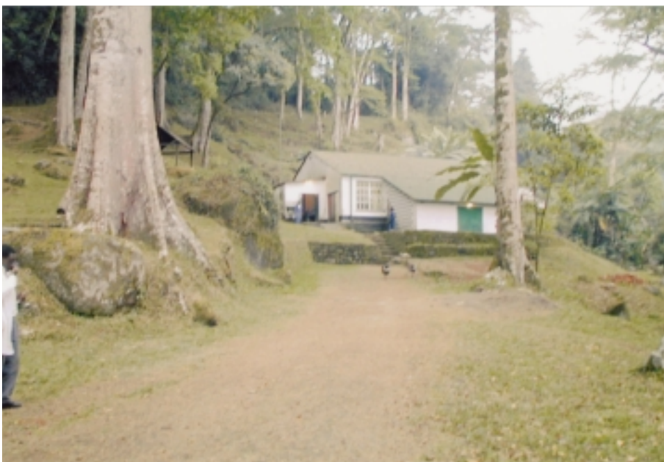
Lejeri Tea Estate, Ruo power station 発電所建物
