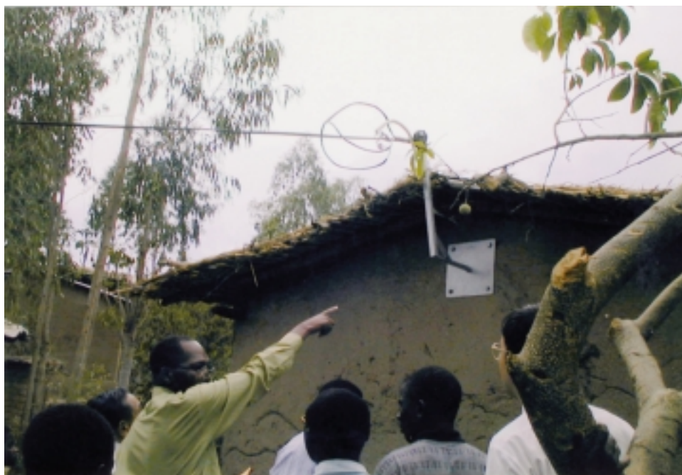
わら葺屋根の 民家への引込み線 取り付け
