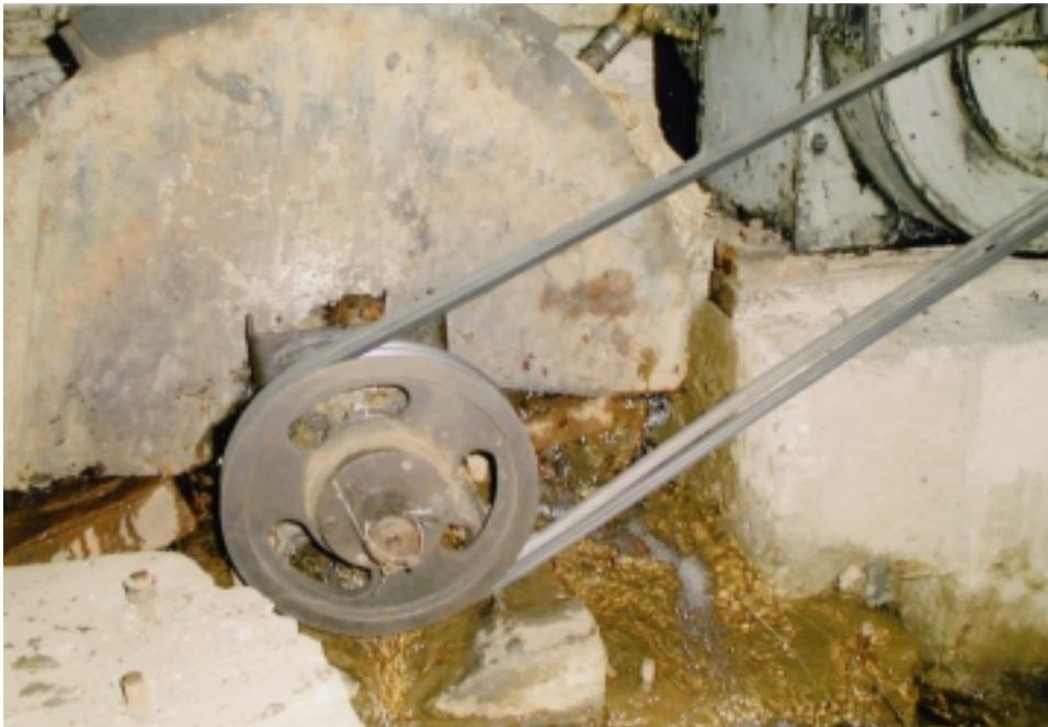
Matandani Mission 水力発電所水車 右上が発電機
