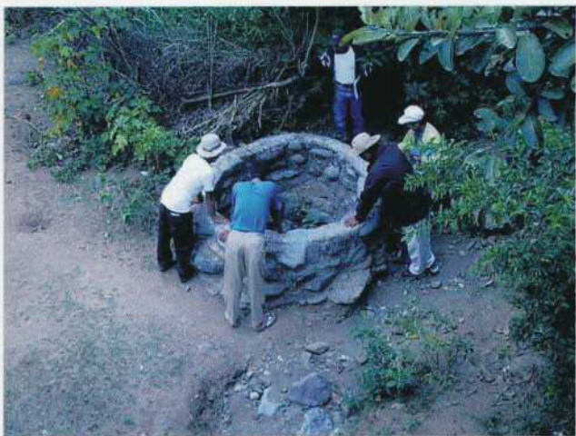
No.2 Playas 河川沿いにある既存手堀り井戸 深度は約3mで現在は水面は無く使用されていない
