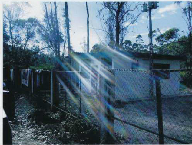
No.1 Catacocha 既存井のコントロール小屋 深度は10mと浅いが水質は良い 調査時にはポンプの故障で稼動していなかった
