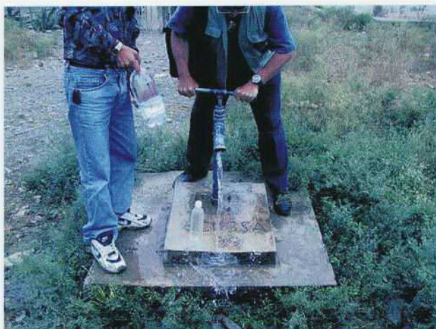
給水状況① 深度40mのハンドポンプ 塩分が含まれているので飲用としては使用されてい ない
