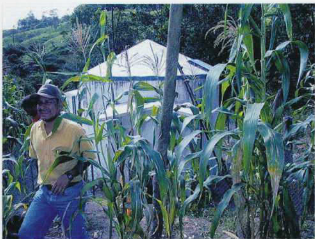
No.1 Catacocha 既存緩速ろ過池 表流水を引き込んでいる。 エクアドルでは一般的なもののだが、設計に問題がある。
