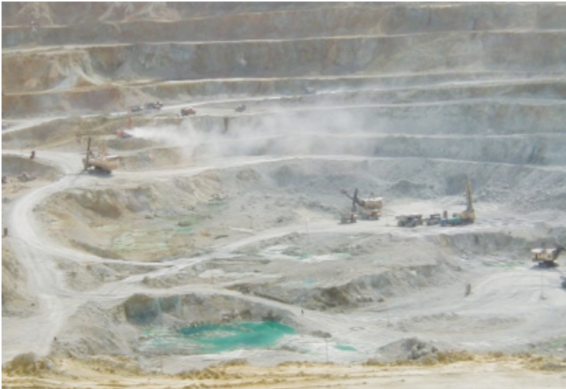
マドネウリ (Madneuli) 鉱山 オープンピット：長経1300m、短経600-700m、深さ約250m (ベンチ約15m × 約18段、ピットの傾斜約45度)
