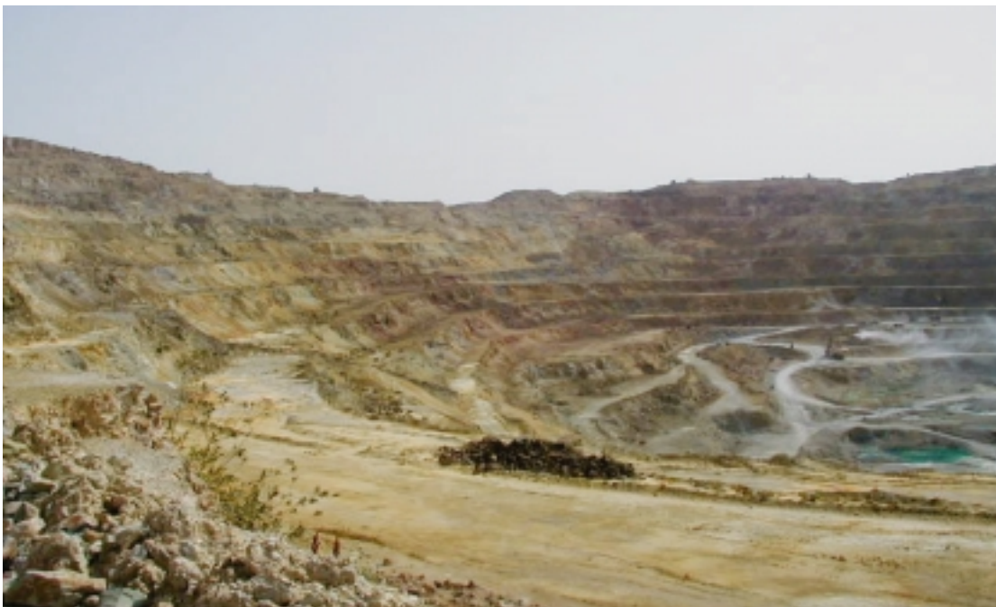
マドネウリ (Madneuli) 鉱山 オープンピット：長経1300m、短経600-700m、深さ約250m (ベンチ約15m × 約18段、ピットの傾斜約45度)
