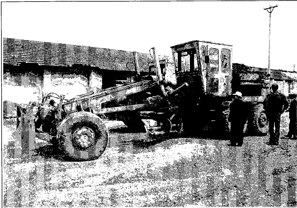
道路建設に使用されているソ連製建設機械
