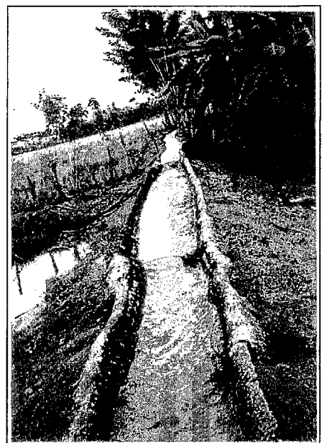
3次水路(モルタルライニング)
