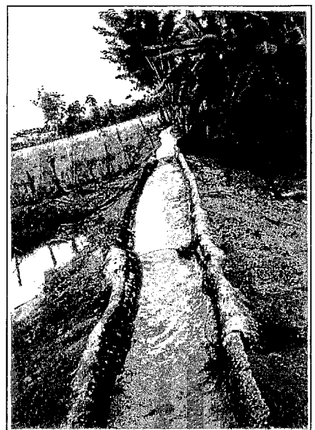
3次水路(モルタルライニング)
