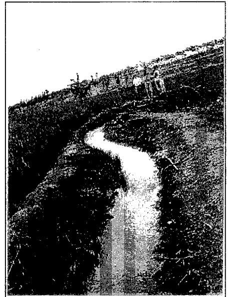
3次水路(土木路)
