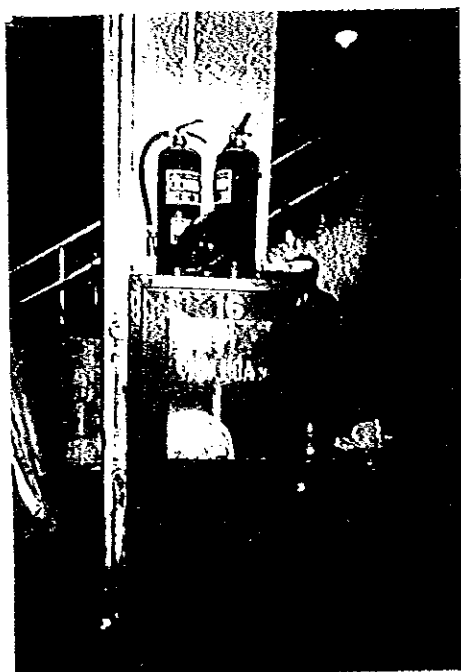
屋内消火栓と消火器
