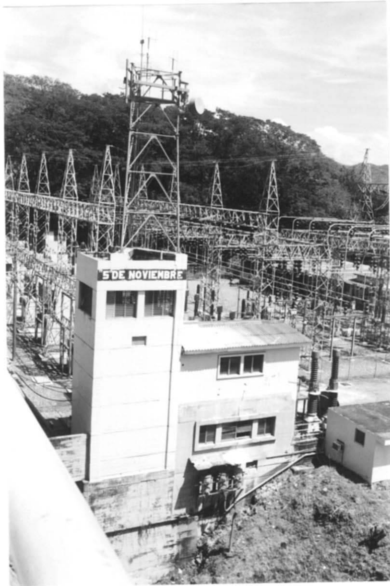
写真6. シンコ・デ・ノビエンブレ発電所
