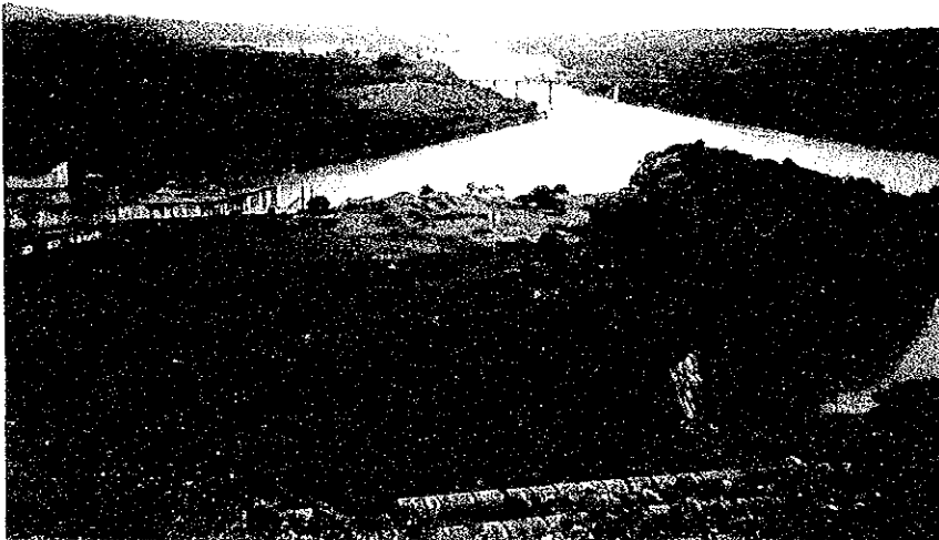
写真2 マガットダム (Isabela州) から見たマガット川下流部。 ダム湖への堆砂による発電量低下が懸念されている。
