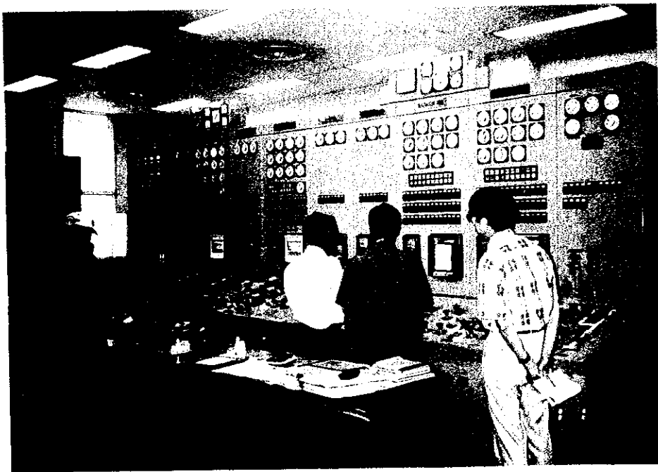
ナムグム水力発電所に設置された制御板
